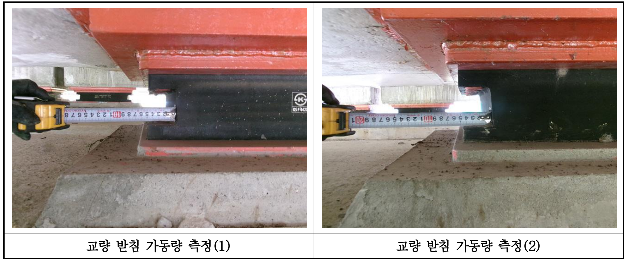
【사진 9.3.15】 교량받침 이동량 측정
