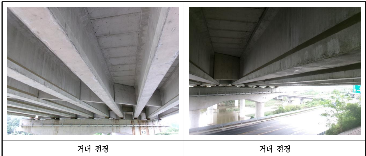
【사진 9.3.4】 거더 전경
