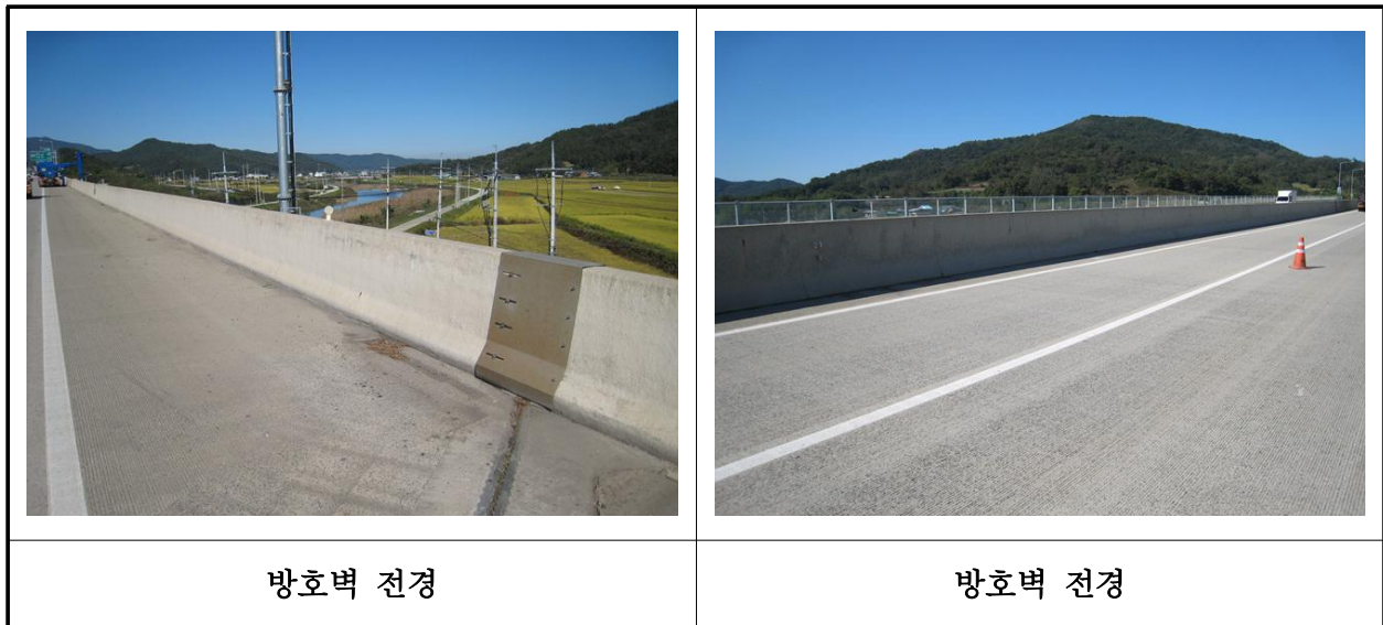
【사진 9.3.23】 방호벽 및 중앙분리대 전경
