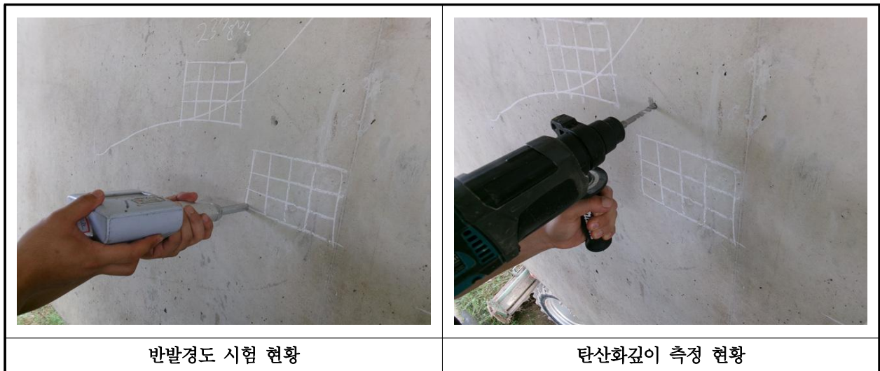
【사진 9.4.1】 콘크리트 내구성조사 현황
