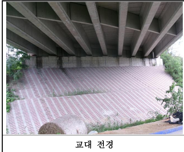
【사진 9.3.8】 교대 전경
