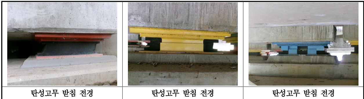
【사진 9.3.12】 교량받침 전경
