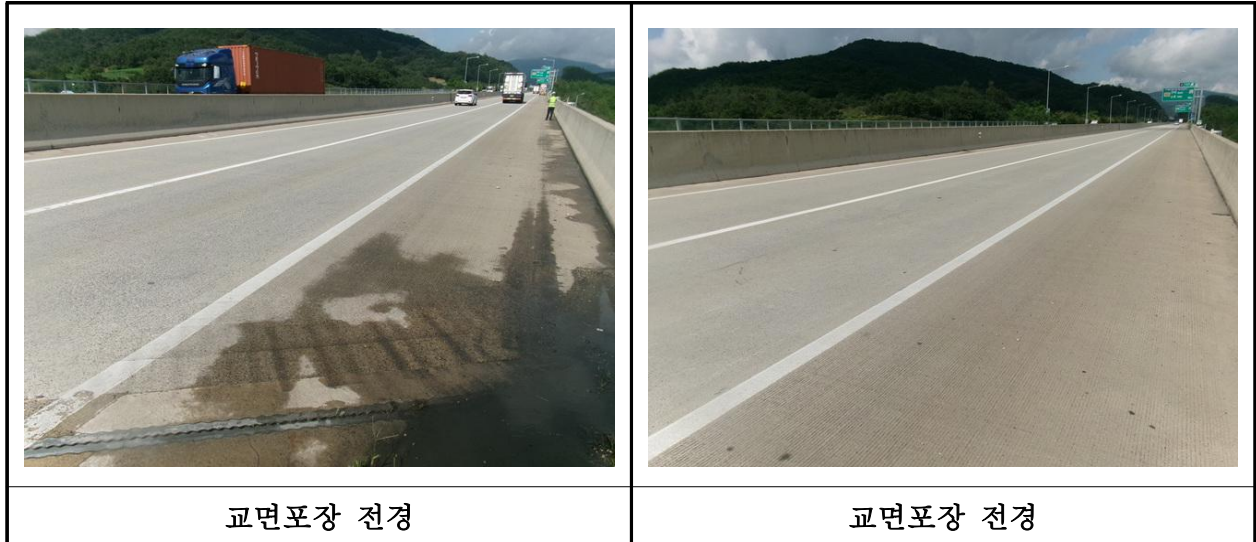
【사진 9.3.19】 교면포장 전경
